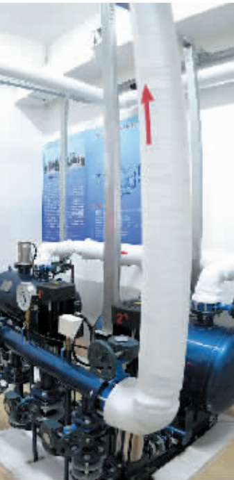
观音峡路新建的供水设施。傅学军 摄
